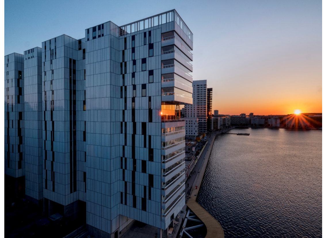
Brohuset, Liljeholmskajen 162 boliger
